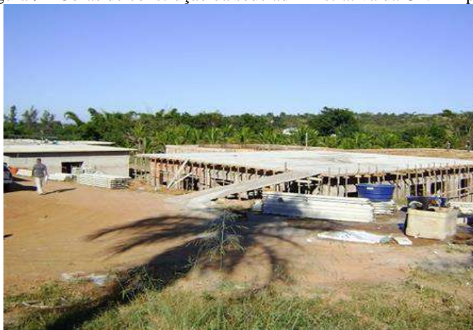
Figura 9 - Obras de construção da sede administrativa da UNED Iporá.
